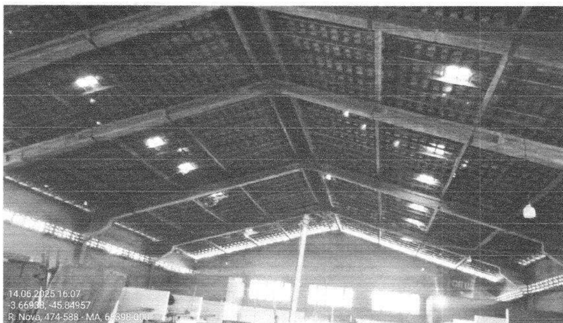
Figura 31: imagem da cobertura
