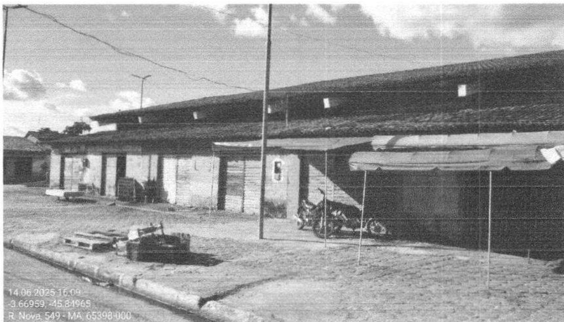
Figura 24: Fachada lateral esquerda
