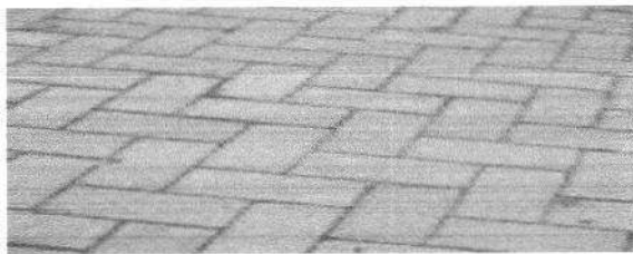
Blocos intertravados de concreto.
