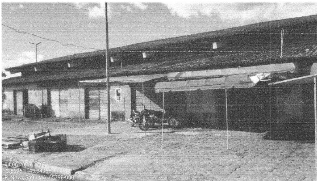
Figura 22: Fachada lateral esquerda
