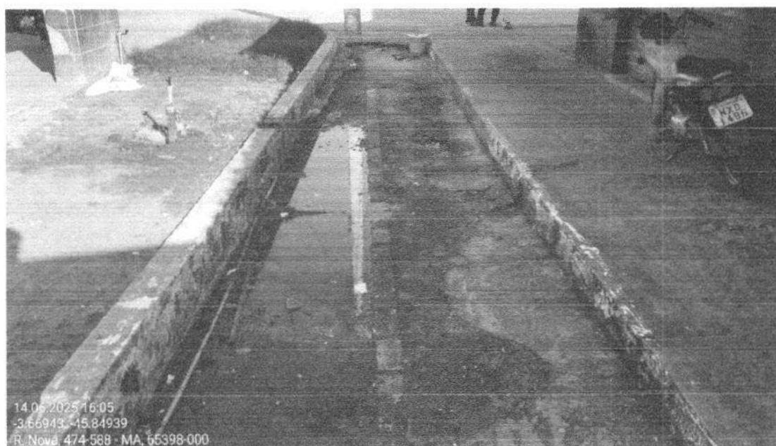
Figura 8: Imagem externa, calçada.
