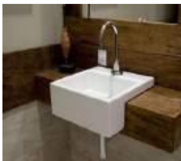
Cuba de semi encaixe L830 e Lavatório L76 PNE, Deca ou similar.
